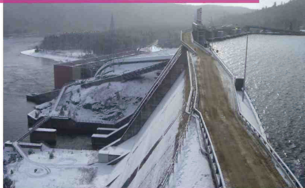
Photo Hydro-Québec : Barrage de La Trenché ▲
