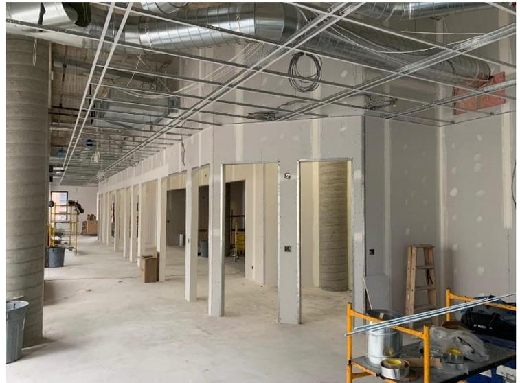
Trame de plafond terminée et installation du système de chauffage/ventilation, 1<sup>er</sup> novembre 2018
